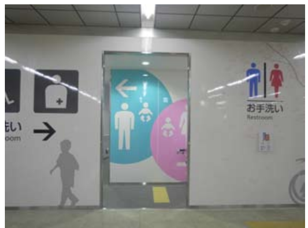
トイレ入口/段差をなくして、ゆるやかなスロープにしました。入口正面には大きな男女サインを設けました。
