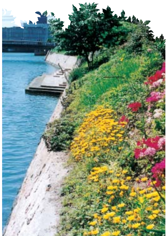
那珂川・大黒橋付近
