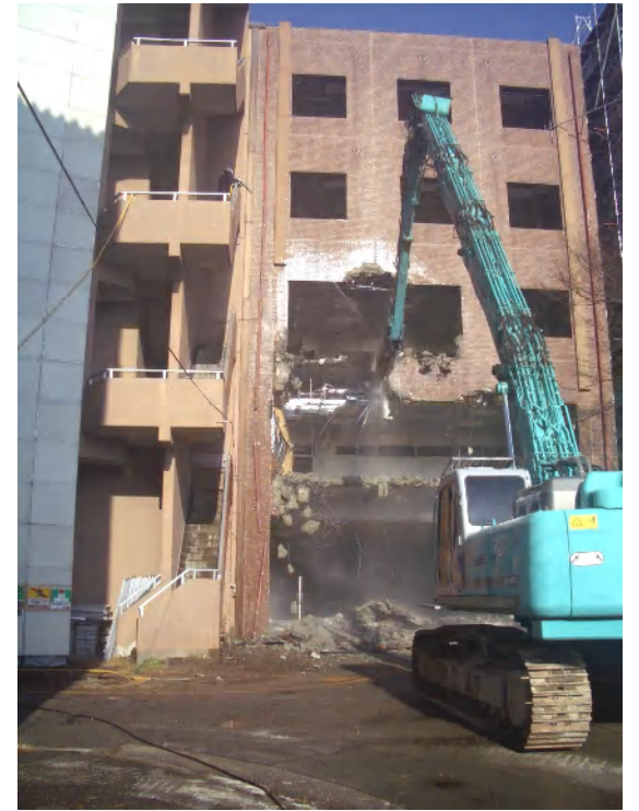
◆UR発注による解体工事(H22.12.20)
