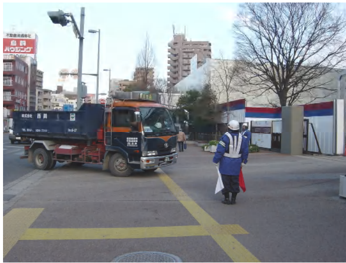
◆工事車両の出入り口となる正門と歩行者等の安全を確保する交通整理員(H23.1.14)
