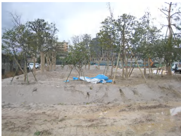
◆グラウンドに設けられた仮植地ここに樹木や表土が仮移植されています。(工事期間中) (H22.12.14)
