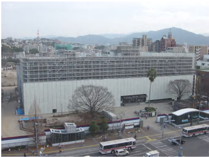
◆足場が全面的に設置され、防音パネルで覆われつつある本館建物(H23.1.14)
