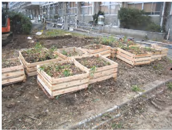
◆本館前の貴重な草本類を表土と一緒に移植します。(表土移植) (H22.12.14)
