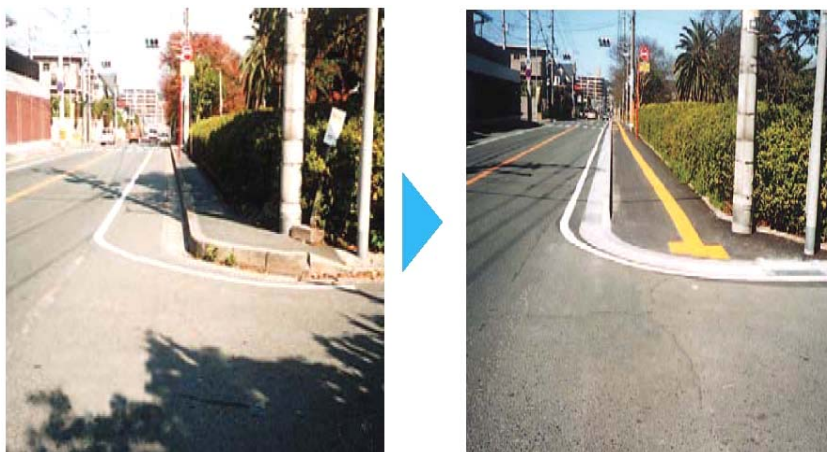
■歩道のバリアフリー化（マウントアップの改善、誘導ブロック設置）
