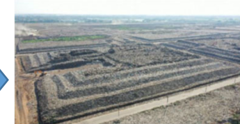
福岡方式による廃棄物処分場の整備（ミャンマー・ヤンゴン市）
