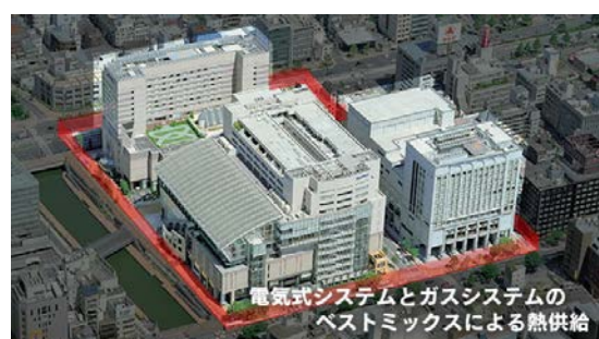
図 2-65 下川端地区（供給区域 2.2ha）
