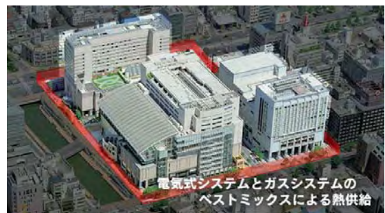
図 2-63 下川端地区（供給区域 2. 2ha） 出典）株式会社福岡エネルギーサービス HP
