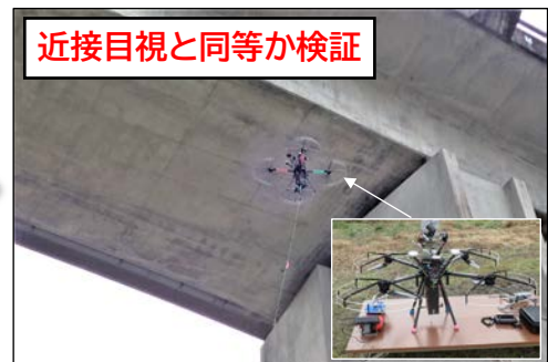
橋梁点検支援技術による点検
