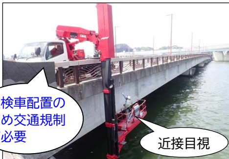
近接目視点検
