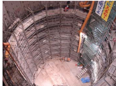
下水道の工事現場見学
