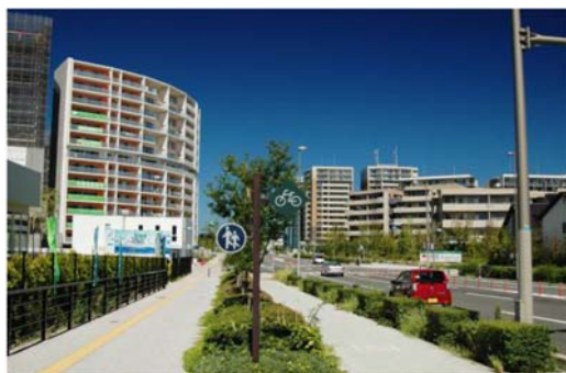
アイランドシティにおいて設置されている自転車走行帯
