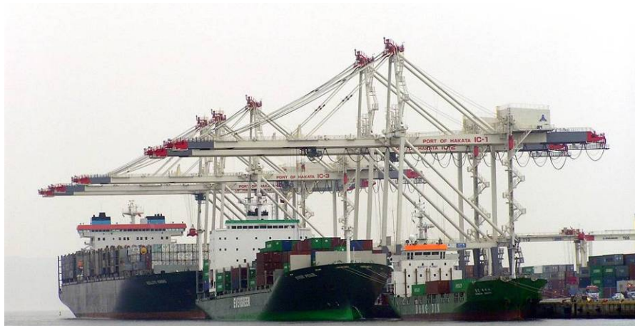
フル稼働中のガントリークレーン
