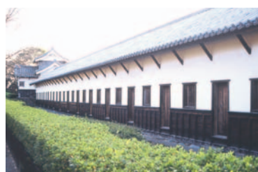
重要文化財 福岡城南丸多間櫓 (奥が西隅櫓)
