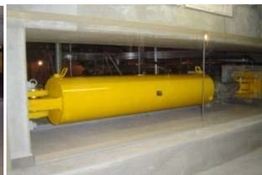
オイルダンパー設置状況
