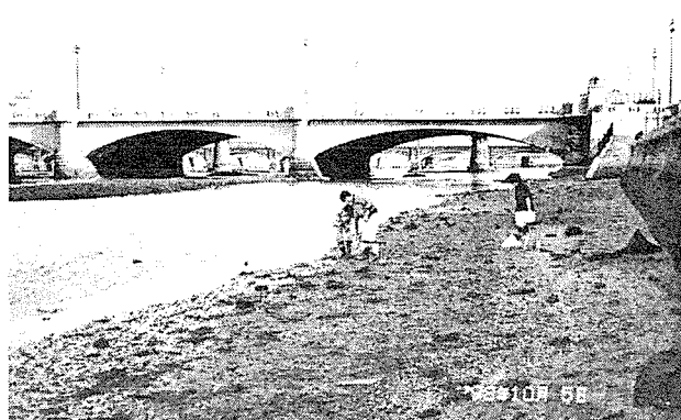
図12 河口下流（下流側から撮影）
