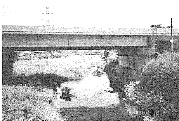
図7 高等橋（下流側から撮影）
