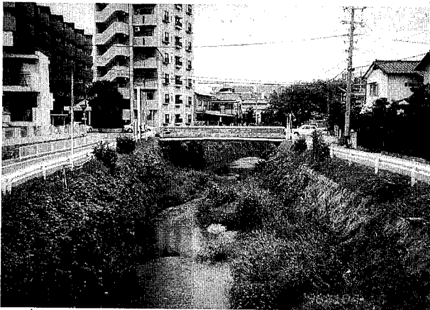
下屋敷橋（下流から撮影）
