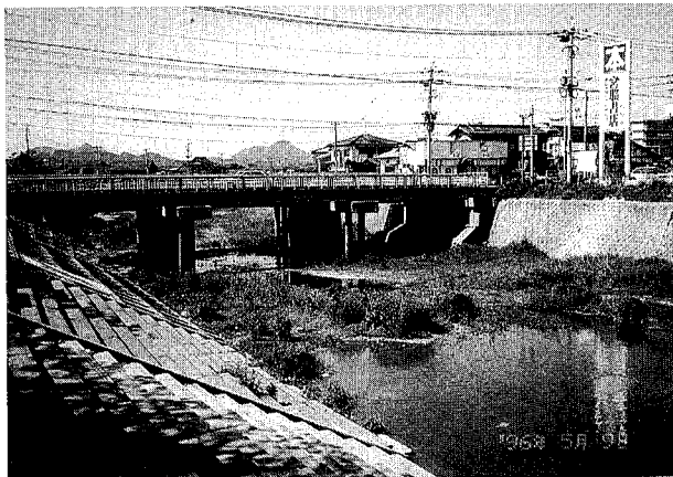
池田川橋（上流から撮影）
