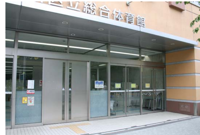
<総合体育館用出入口>
