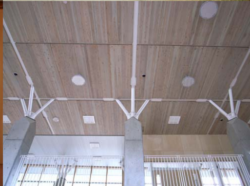
左：木パネル (床材) 右：木パネル (天井)
