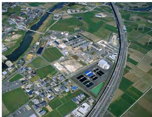
多々良浄水場
