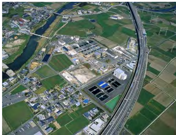
多々良浄水場
