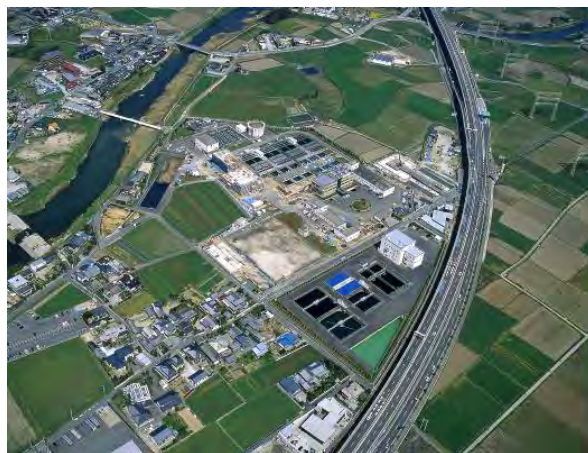
多々良浄水場
