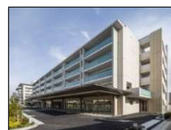
「サービス付き高齢者向け住宅」外観
