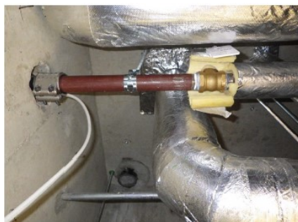
給水管根元(プラグ止め前)
