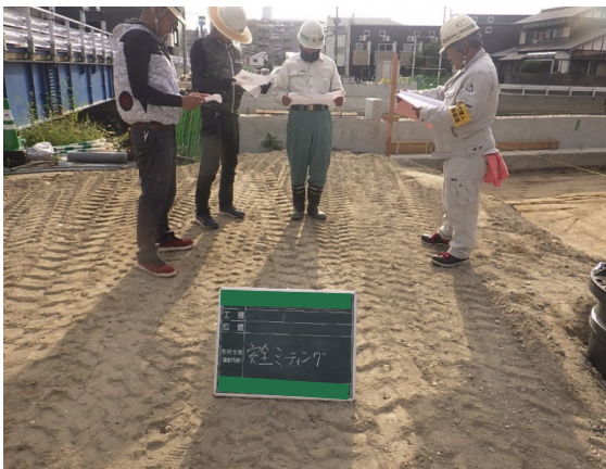
現場にて安全ミーティングを行いました。
