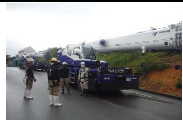
移動経路確認状況
