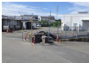
露出配管単管養生
