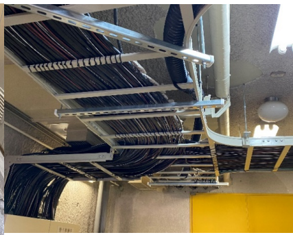
天井断熱材剥離状況
