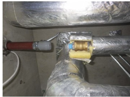
給水管根元(プラグ止め後)
