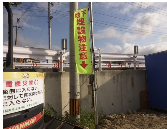
地下埋設物付近にのぼり旗を設置して、注意喚起を行います。
