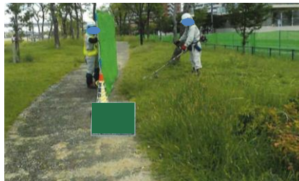
飛び石防護状況と 飛び石しにくい機械での作業
