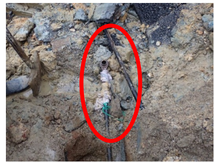
給水管φ20mm破損
