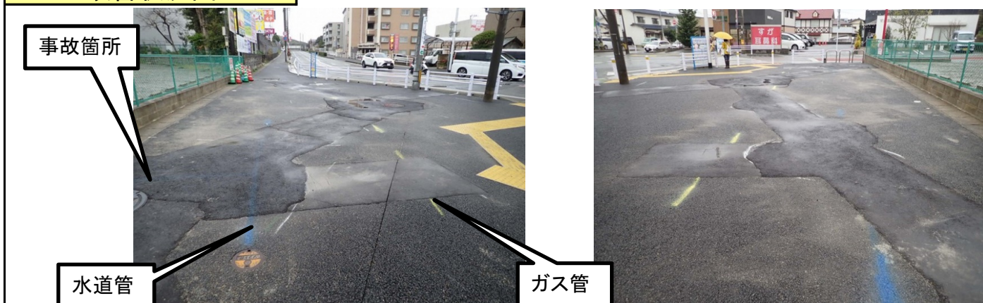
給水管φ20mm破損
