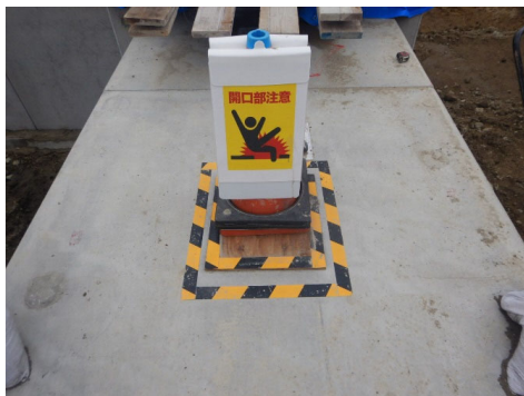
落下防止蓋設置及び表示板設置
