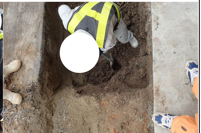
人力掘削作業状況
