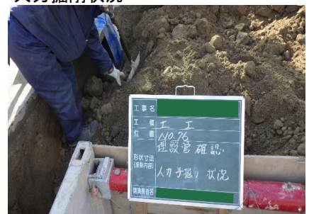
人力掘削状況
