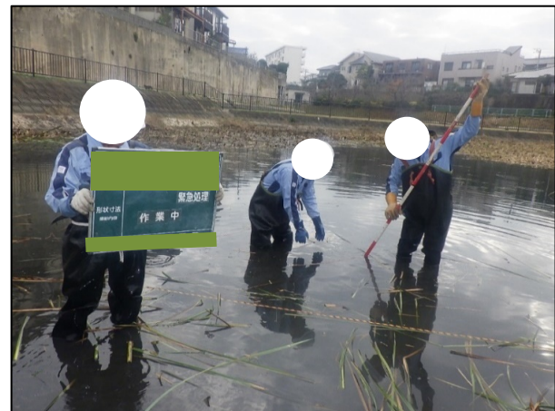
作業前の安全点検
