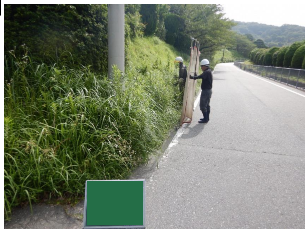
防護ネット使用
