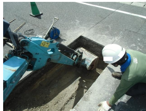
刃先誘導員の設置
