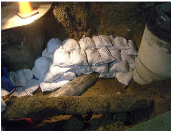
仮排水管φ300に追加してφ400を2本設置
