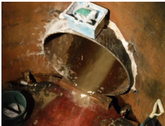
ケーシング内部にφ900の仮排水管を設置
