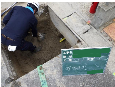
地下埋設物付近の人力掘削
