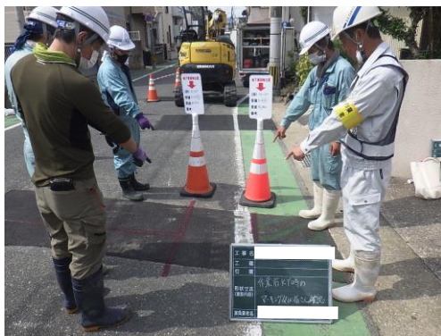
朝礼時の地下埋設物位置情報の掲示と指さし確認
