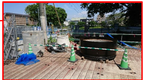
雨水管保管状況
