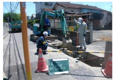
合図者の配置及び合図による掘削の徹底
