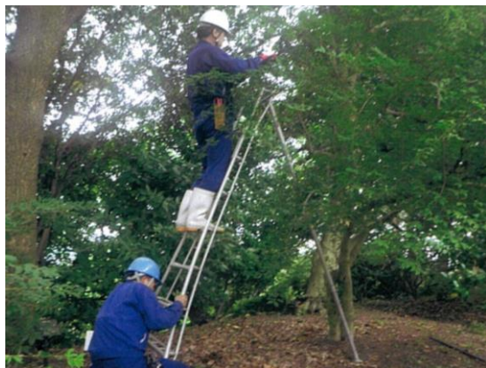
高所作業時の2人体制の徹底, 補助員の配置
