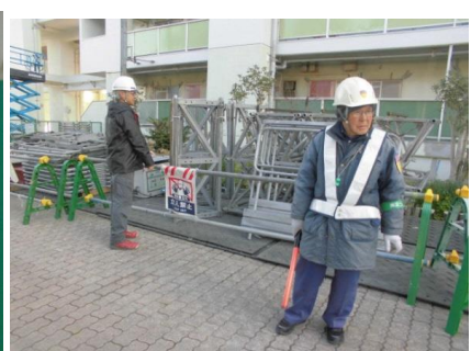
・作業責任者巡視状況
