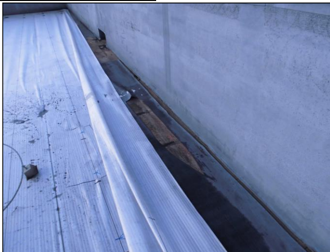
既存防水撤去状況
