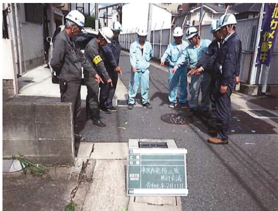
地下埋設物位置の指さし確認
