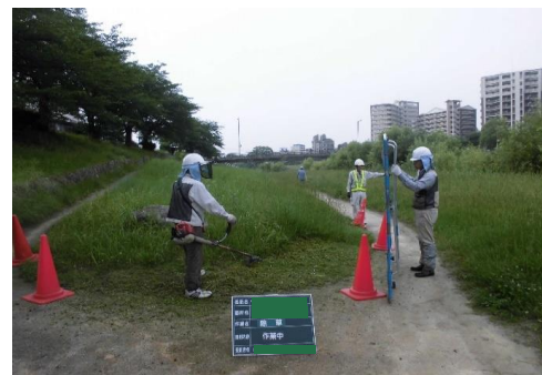
作業員の適正配置 (2人1組で、安全担当者の監視の下、作業を行う)
