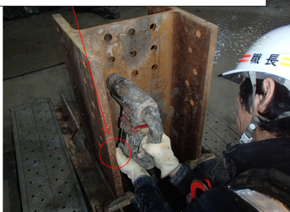
※締付け作業時、シャーレンチ本体が重い(7.1kg)ため、左手を下から支えていた。
