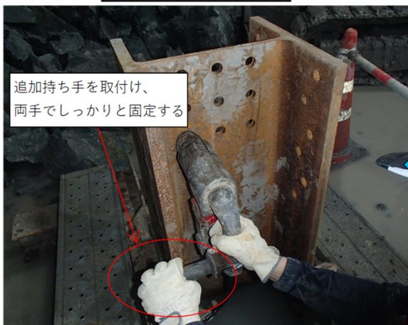
※追加持ち手を取付ける事により、固定しやすくと共に、フランジ内に手が入らないようにした。
