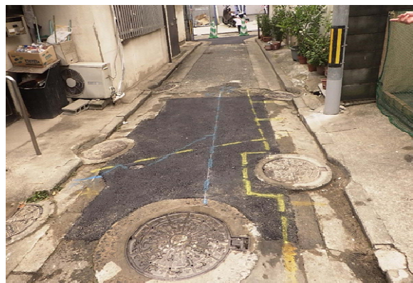
地下埋設物のマーキング
