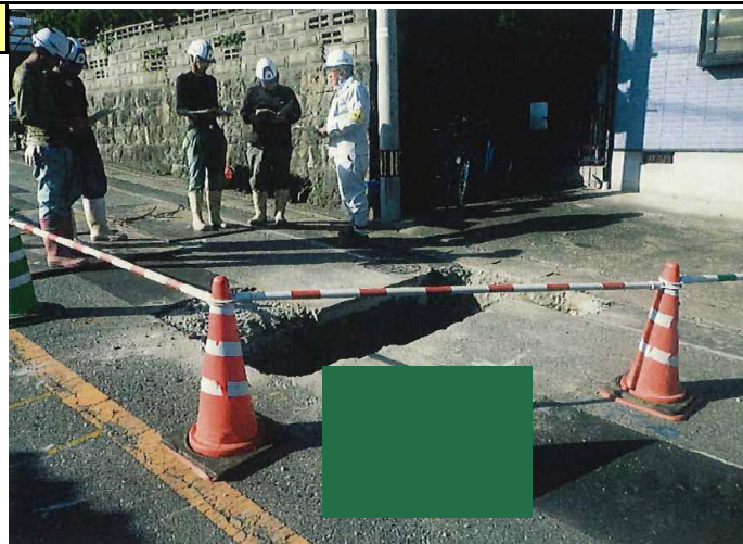
再発防止に向けた安全訓練を実施(コーンバーを設置し、交通区域を分離)
