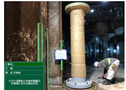
作業手順書を作業現場に掲示
