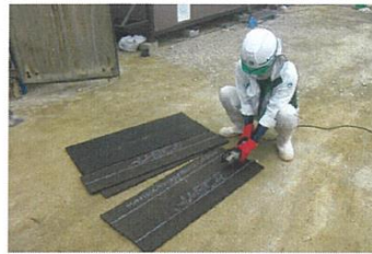
ディスクグラインダーによる試し切断中
