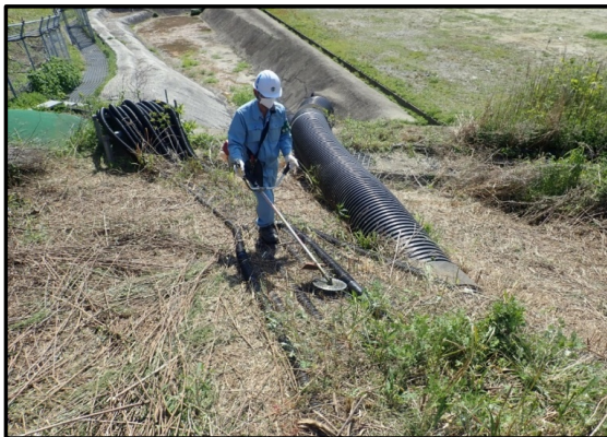
除草作業状況
