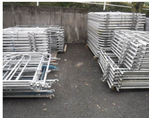
資材周辺におけるスペース確保状況
