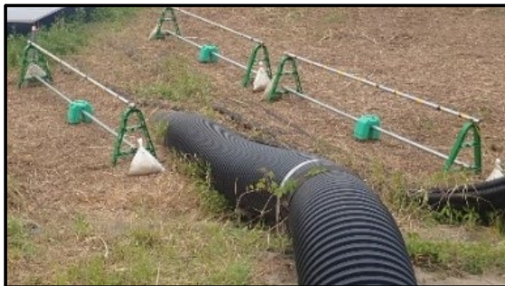
障害物エリアの明示
