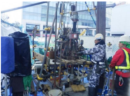
改善状況(全景)
