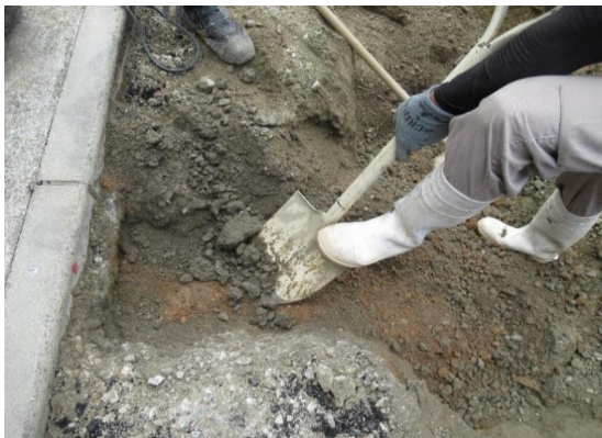
・先行人力掘削にて、水道管(給水管)の位置を確認後、機械掘削を行う。 (その際、監督員立ち合いを行う。)
