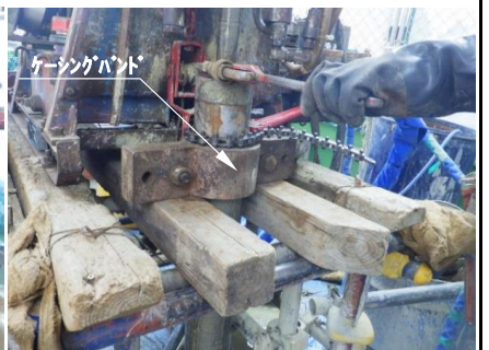
ケーシングバンド使用状況
