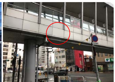
化粧鋼板復旧完了
