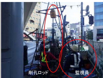
ロッド1本毎の脱着及び監視員配置状況
