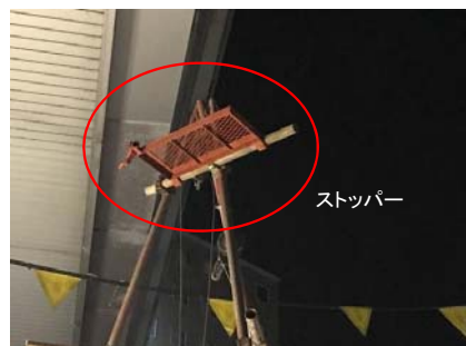
ストッパー設置状況
