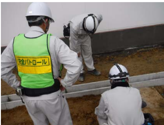
複数名による安全巡視状況
