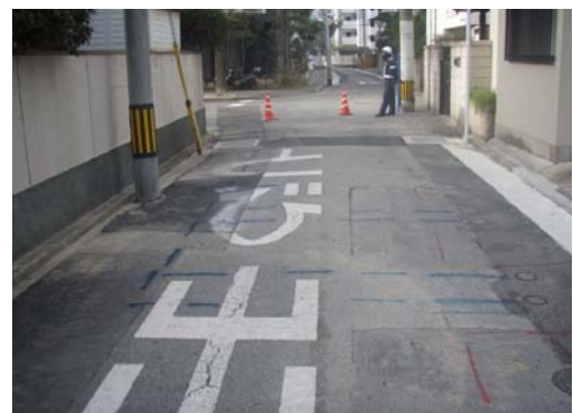
給水管分岐箇所のマーキング
