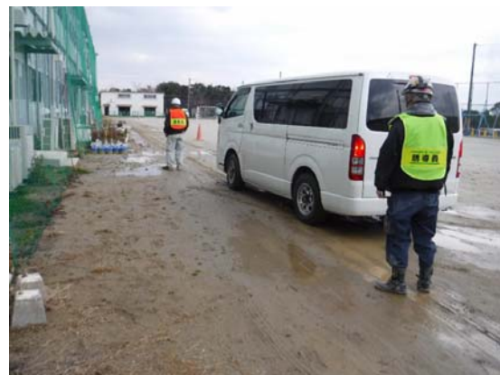
交通誘導員を配置しての工事車両運転状況
