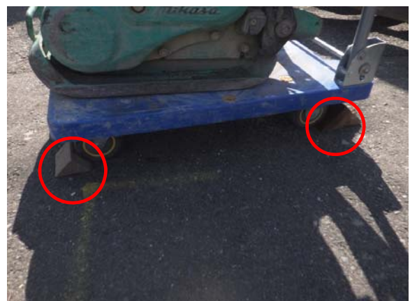
歯止め設置状況
