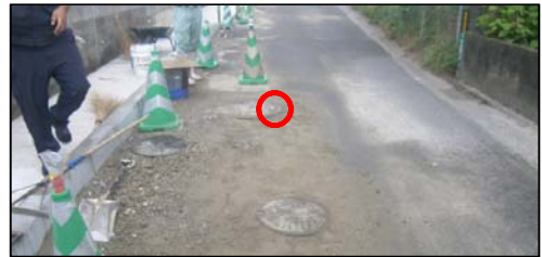
□事故発生箇所
