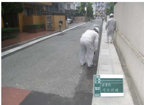
作業前安全巡視
