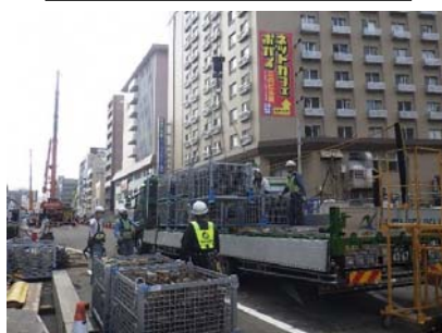
現場荷卸し状況
