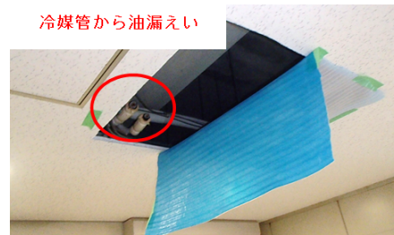
天井状況写真
