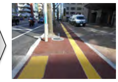
御供所井尻3号線(祇園大通り)(事業後)
