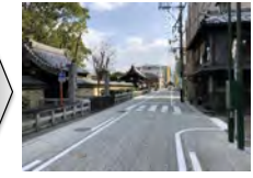
御供所297号線外(御供所通り)(事業後)
