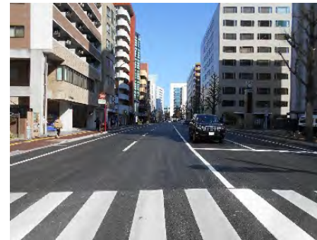
御供所井尻3号線（祇園大通り）（事業後）
