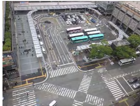
博多駅筑紫口駅前広場（事業後）
