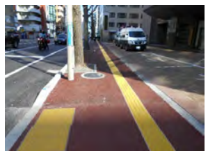
御供所井尻3号線(祇園大通り)
