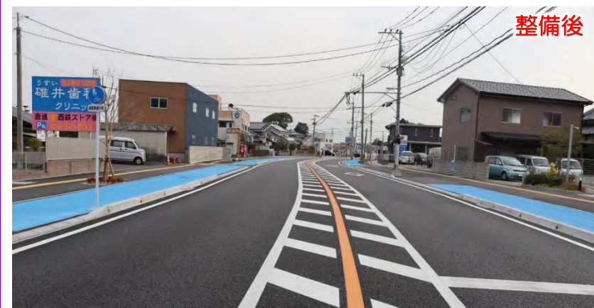
（一）周船寺有田線（橋本2工区）
