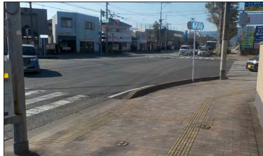
交通安全対策実施前の交差点
