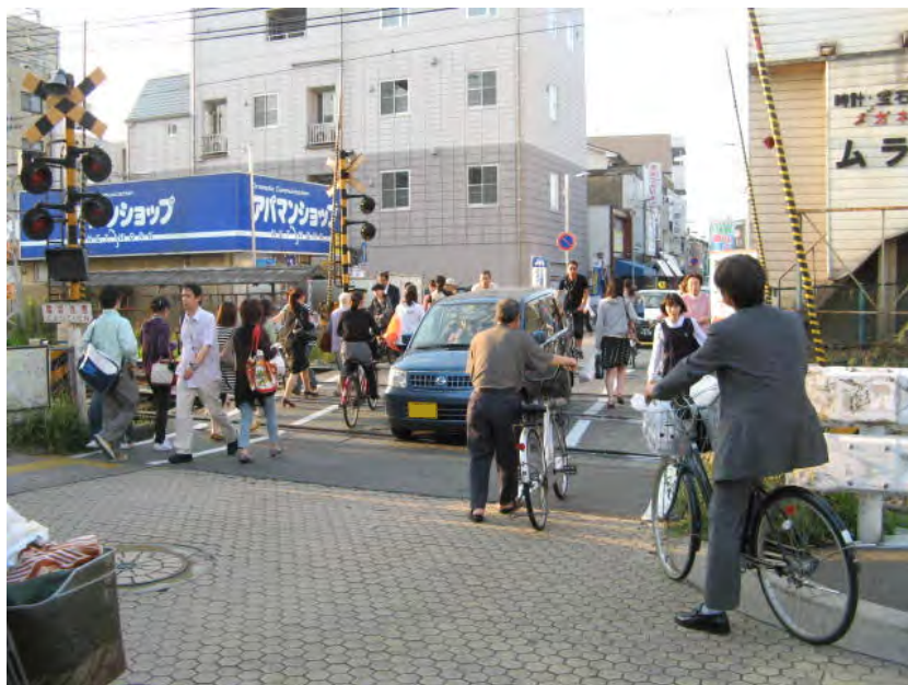
歩行者の滞留により自動車と輻輳する踏切 (雑餉隈1号踏切)
