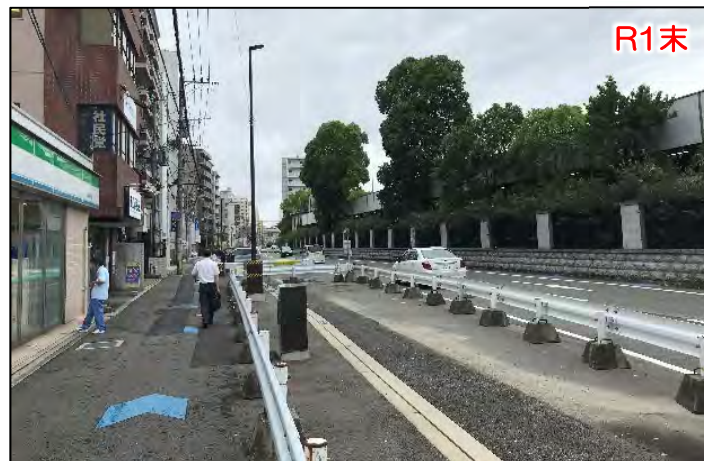
(都) 博多箱崎線 (千代・馬出工区)
