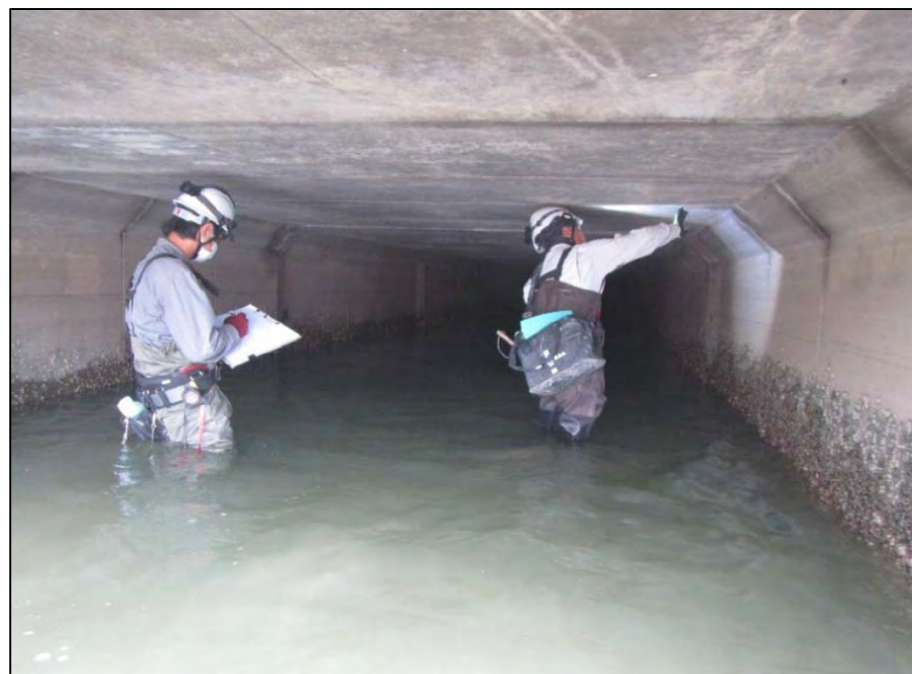
ボックスカルバート内の写真（平均水位0.7m）
