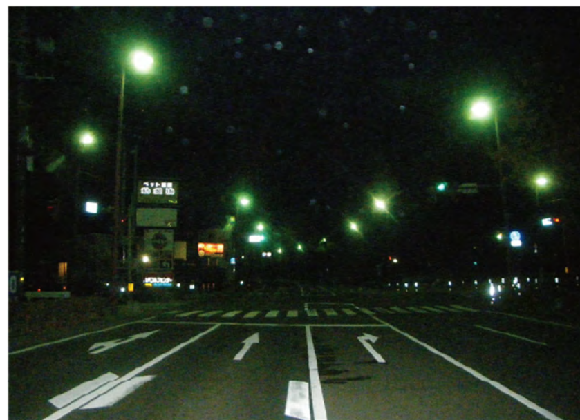
LED化前の道路照明灯（水銀灯）
