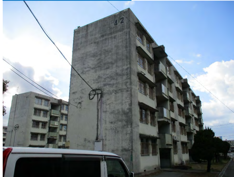
建替前(市営城浜住宅)
