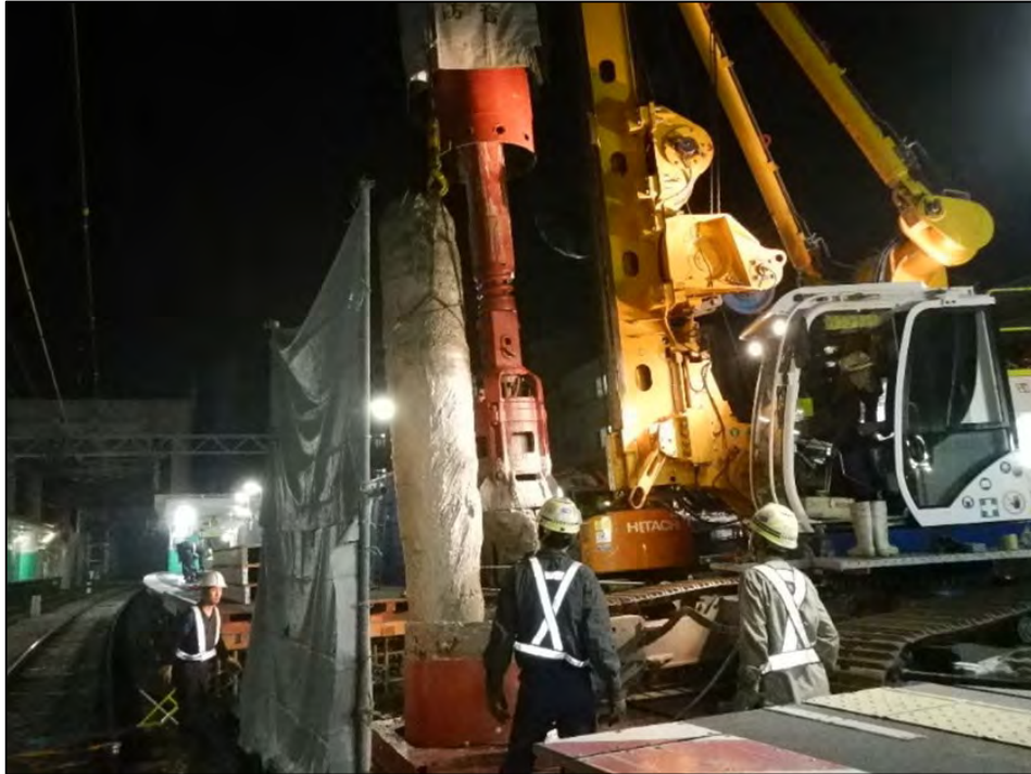
支障杭撤去状況
