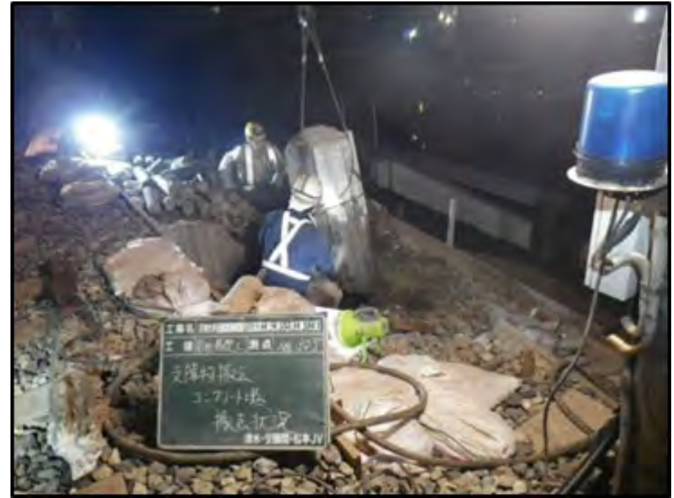
埋設基礎撤去状況
