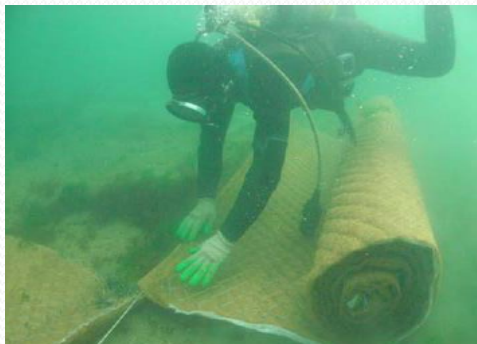
海底へのアマモ種子シート設置状況
