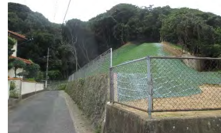
【鴻巣山特別緑地保全地区】法面改修工事
