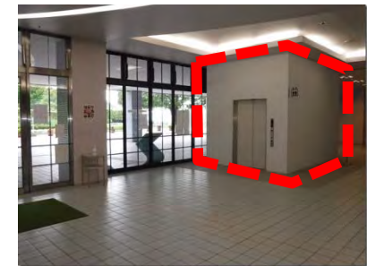
レベルファイブスタジアムエレベーター改修
