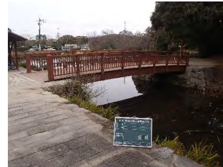
【舞鶴公園】木橋改修工事
