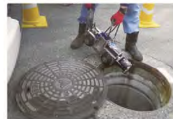
管路の調査状況
