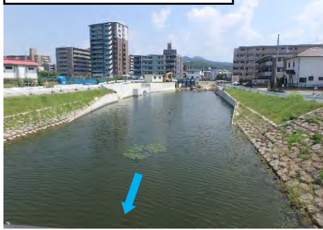
河川改修後(周船寺川)
