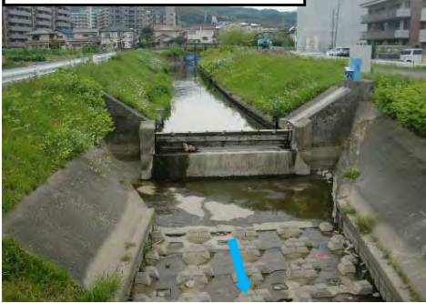
河川改修前(周船寺川)
