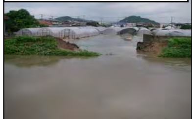
周船寺川破堤の状況(H21)
