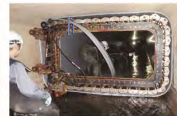
管路の更新状況
