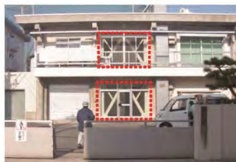
耐震化の事例 (ブレース設置)
