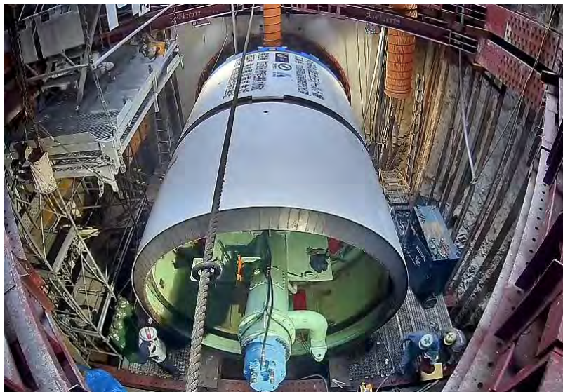
○雨水幹線工事 シールドマシン（令和3年7月）
