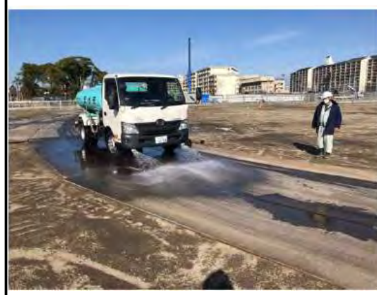
道路汚損・粉塵対策（タイヤ洗浄・散水）
