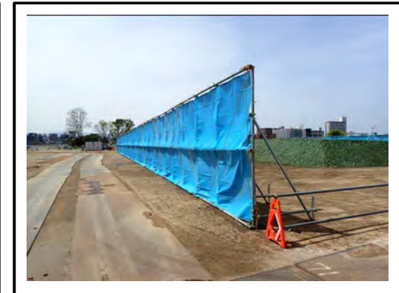
粉塵対策（残土仮置き時の養生）
